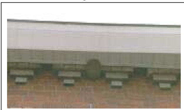
Fig. 12: Half nest geklemd tussen uitspringende gevelstenen in Avelgem: Stationstraat nr. 11
