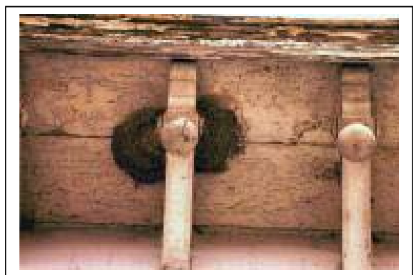
Fig. 19: Onderzijde van de gevel in Bossuit
