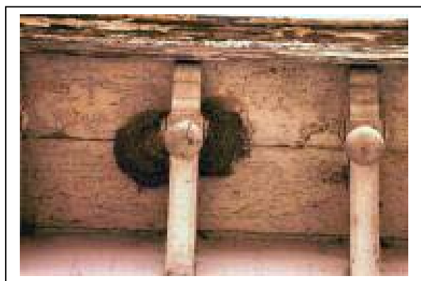
Fig. 19: Onderzijde van de gevel in Bossuit
